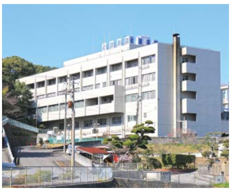
▲建て替えが決まった永康病院。スムーズな診療体制を提供するため、電子カルテを導入します
