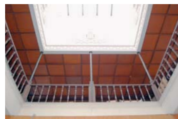
▲吹き抜けと天窓
