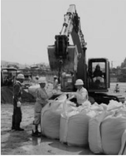
6月16日、三豊市建設業協会が豊中町の旧香川松下寿電子工業跡地で防災訓練を行いました。訓練はバックホーによる大型土のう（トン袋）製作・築堤訓練および人力による土のう作り・土俵積み作業・積み込み・運搬訓練で、それぞれトン袋20個、土のう1400個を作り、各支所に備蓄しました。
