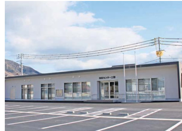
▲完成した市民センター三野
