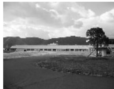
大型ショッピングセンターが建設される予定の旧松下寿電子跡地
