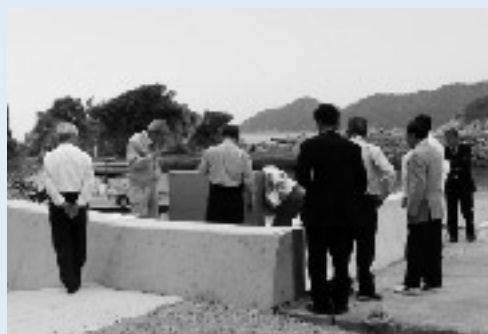
▲ 生里漁港護岸改良工事
