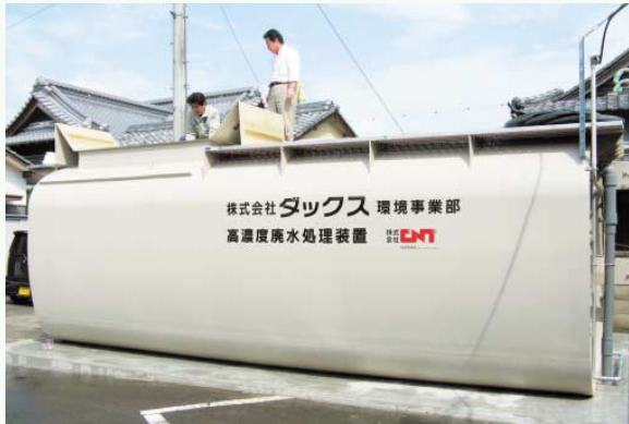
▲高濃度の排水を処理する装置
