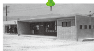
昭和34年 高瀬駅に改築
