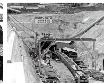
▲建設中の香川用水阿讃トンネル下口 昭和46年(1971年頃)
