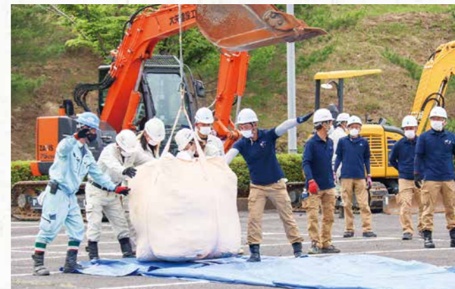
▲大型土のうを積み立てます
