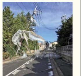
▲飛来物による電柱被害
