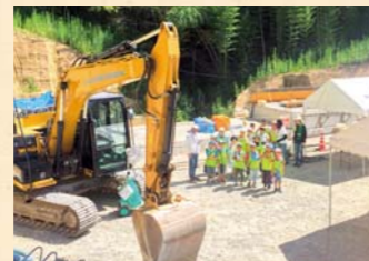
▲砂防ダム建設現場を訪れ、ダムの役割などを調査しました
