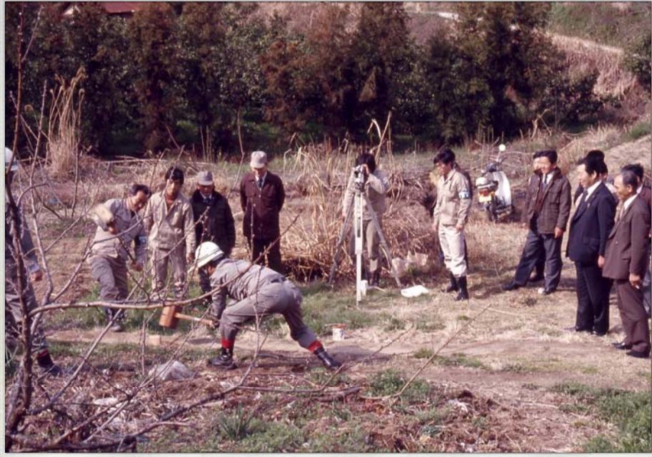
懐かしの1枚 四国横断自動車道 三野地区杭打ち 昭和54(1979)年
