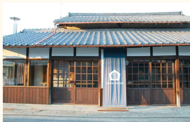
▲JR 本山駅から徒歩1分の場所にある築50年の空き家を改修。物件は市の空き家バンクを活用しました
