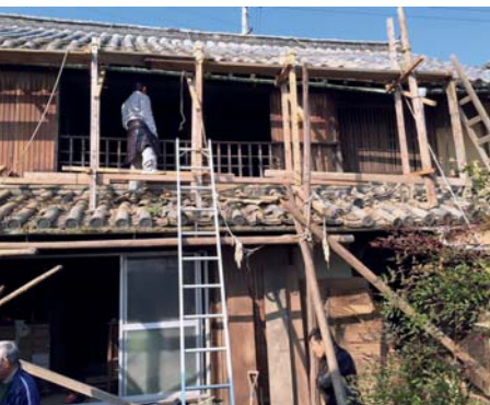
▲雨漏りしていた屋根は自分たちで瓦を付け替えました
