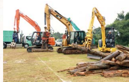
▲倒壊家屋を想定して、重機で撤去
