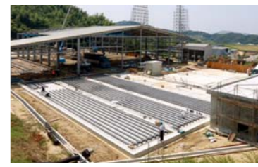
▲整備工事中の施設
