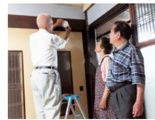
火災報知器の取り付け
