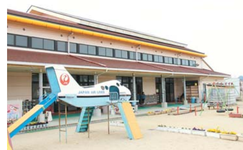
保育室が増築予定の高瀬中央保育所
