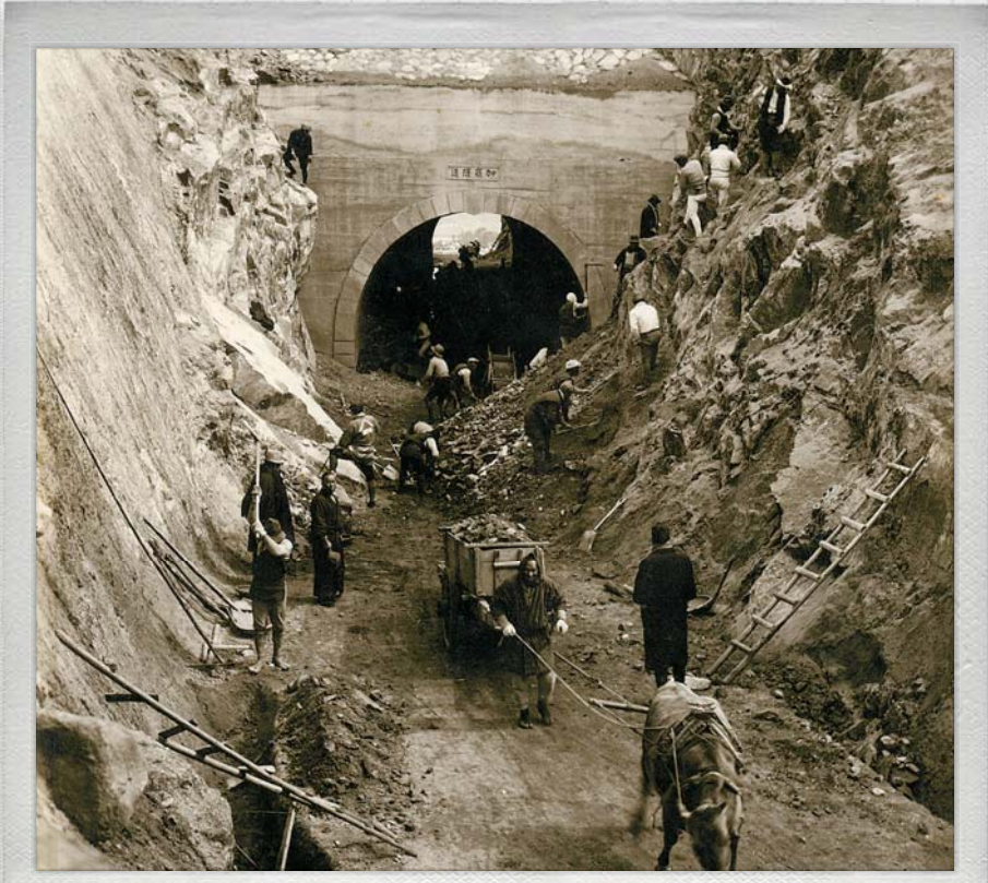
懐かしの1枚 加嶺トンネル 昭和7年・仁尾町
