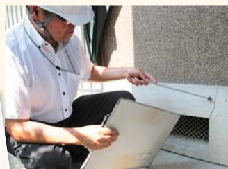
基礎のひび割れ等がないか打診
