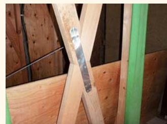
補強の一例 (筋交いを入れたところ)
