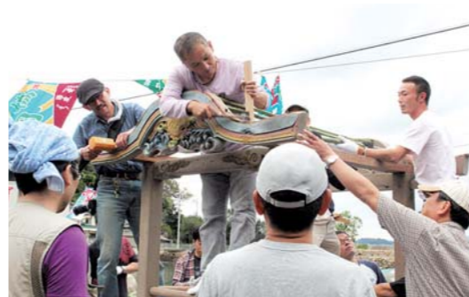
▲釘などを一切使わず ほぞ穴とくさびだけで固定
