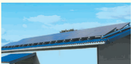
▲設置された太陽光パネル
