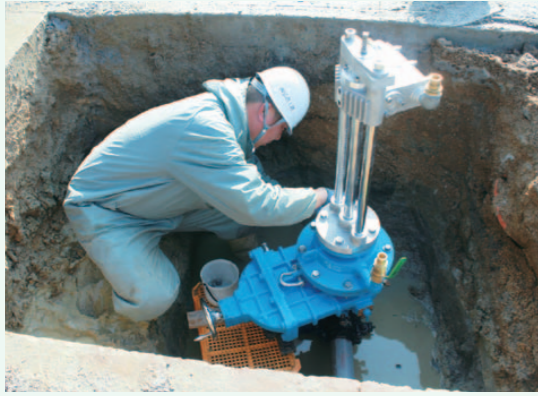
▲ストッパー工法による水道工事
