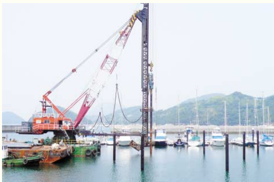
仁尾港係留施設整備工事
