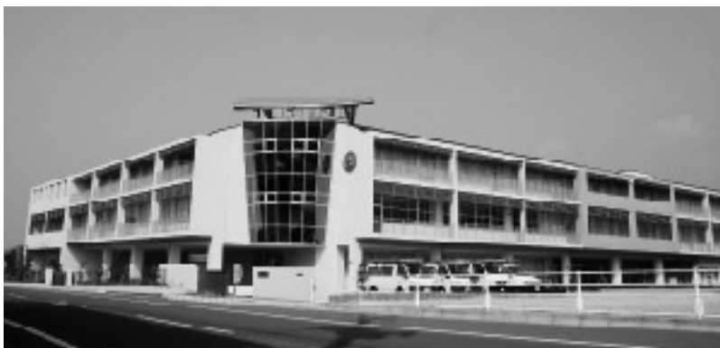
高瀬中学校に整備された太陽光発電システム
