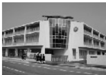
高瀬中学校建設事業
