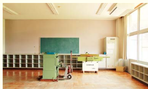
▲教室は作業部屋に改装中。木材加工用の機械が搬入されています
