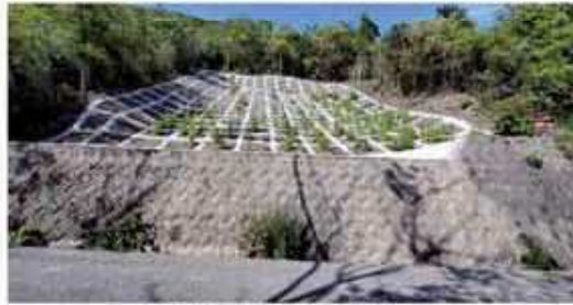
③崩落した斜面の修復状況
