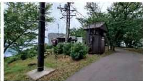
③9 防災無線基地局
