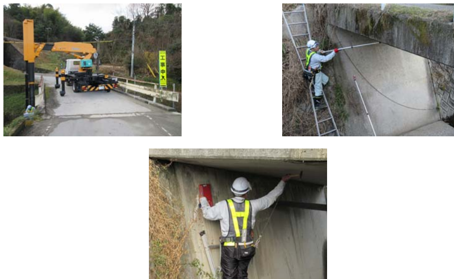
図 3.1 定期点検の様子
