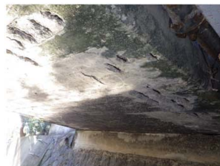
図 1.4 コンクリート橋の損傷状況
