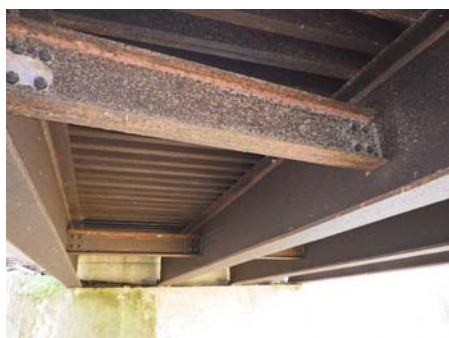
図 1.3 鋼橋の損傷状況
