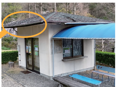
▲撤去予定の豊中町不動産の滝 カントリーパークの建物
