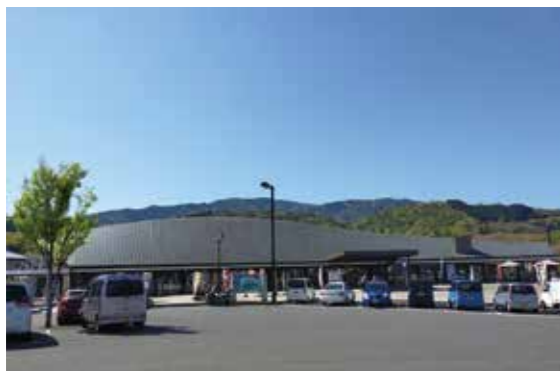
▲改修された「道の駅たからだの里さいた」
