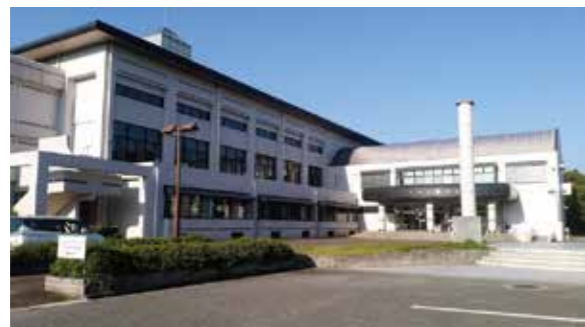
▲防災拠点強化される三豊市総合体育館
