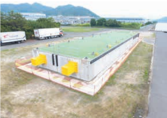
▲栗島港に設置予定の浮棧橋
