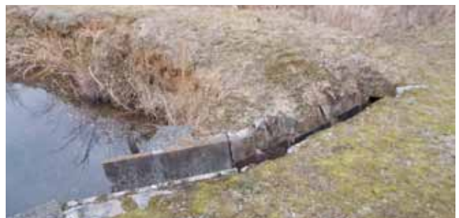
▲老朽化したため池の洪水吐
