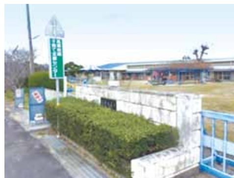
▲高瀬地域子育て支援センターの改築存続の希望は…
