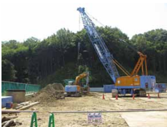
▲北部火葬場障害物撤去工事の様子
