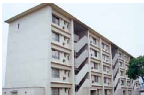
▲雇用促進住宅高瀬宿舎
