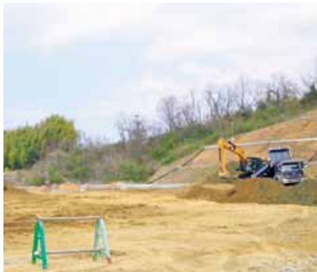
▲次期ごみ処理施設建設予定地
