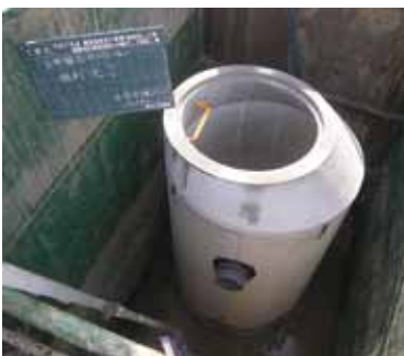
▲粟島潟満地区機能強化工事の状況
