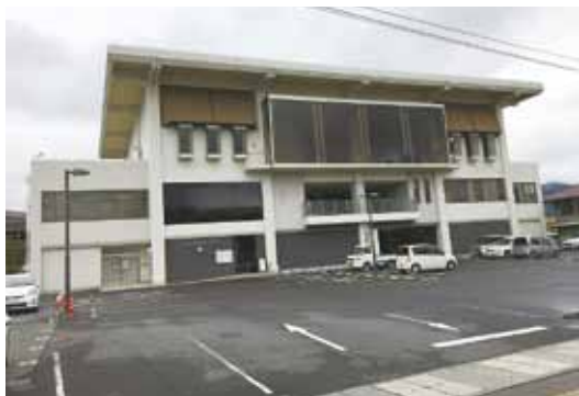
▲2階を高瀬町公民館として改修する高瀬町農村環境改善センター
