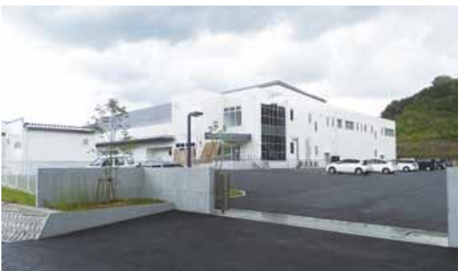
▲公設民営による南部学校給食センター
