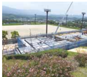
▲建設が進む財田小学校
