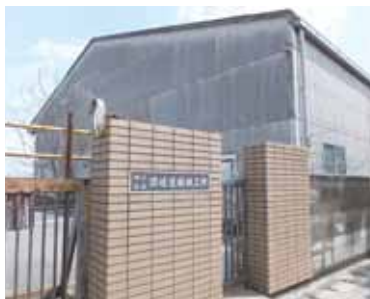
▲讃岐造船所跡地
