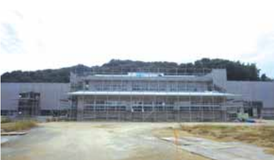
▲建設中の山本地区新設小学校
