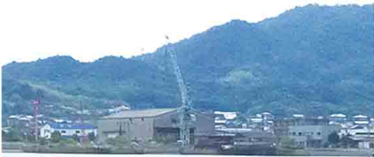
▲詫間港の重要な拠点にある讃岐造船所跡地(大きなクレーンが見える)
