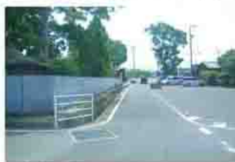
▲市道市道線改修
