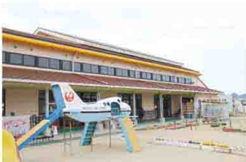
▲保育室が増築中の高瀬中央保育所
