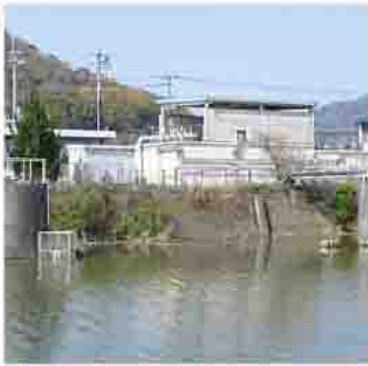
▲河川水の水質悪化と施設老朽化により閉鎖した詫間浄水場
