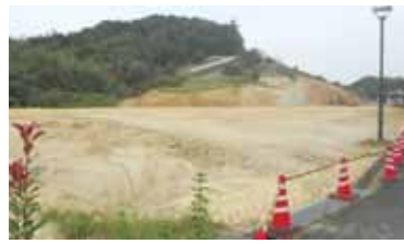
▲造成が進む新設財田小学校建設予定地
