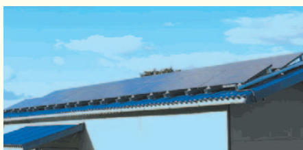
▲設置された太陽光パネル
