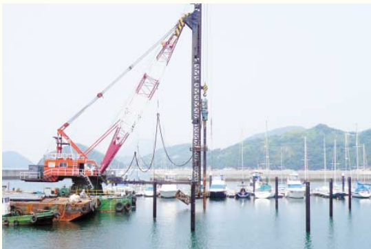
▶ 仁尾港係留施設整備工事
