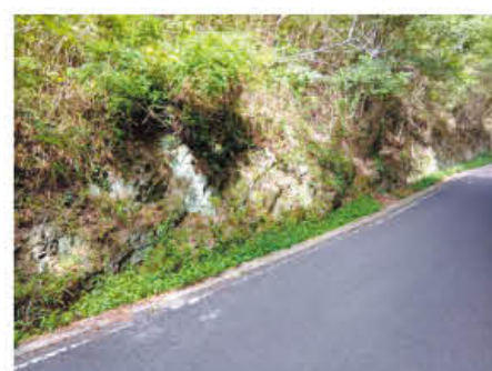
▲ 改良工事を行う林道豊中七宝山線
