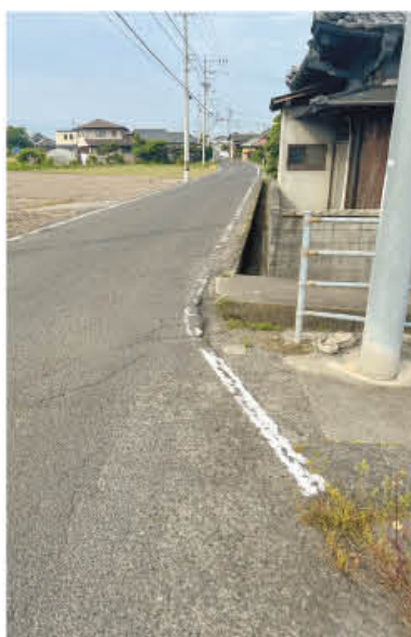
▲歩道が未整備で危険な通学路の一つ (豊中町笠田竹田地区)
