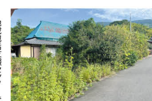
▲放置空き家にならないようにすべきことはある
