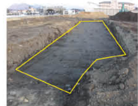
▲ 産業廃棄物埋め戻しをした現場
