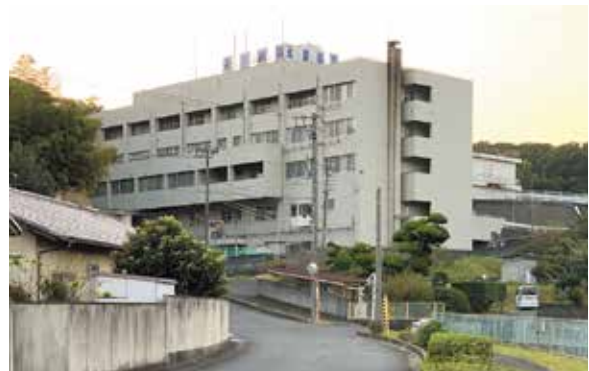
▲ 永康病院跡地(予定)に出された避難所建設の要望
