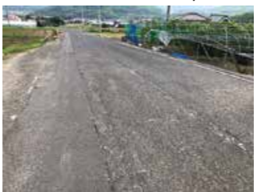
▲消えたセンターラインと車道外側線
