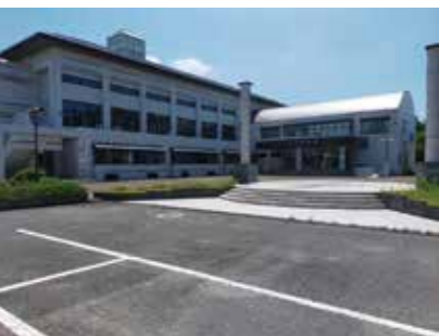
▲ 改修工事される三豊市総合体育館
